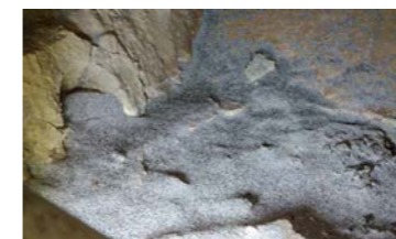
写真4-4. 運転後燃焼炉内
