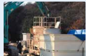
脱水ケーキをセメントで土質改良
