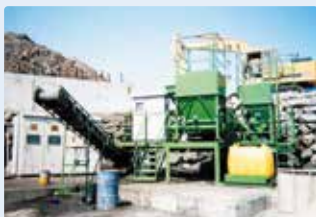
脱水ケーキをセメントで造粒
