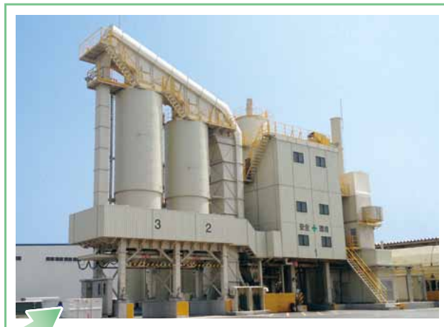
広島県で稼働中の ABD1600CBN
