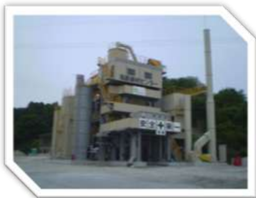
【アスファルトプラント /福島県南相馬市】
