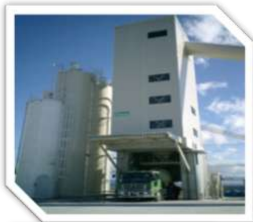
【コンクリートプラント /福井県福井市】
