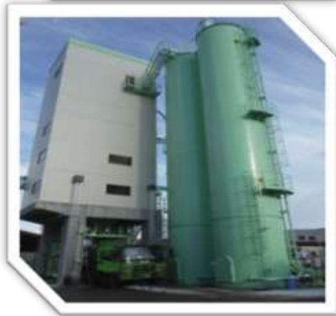
【コンクリートプラント /北海道札幌市】
