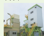
石膏系固材製造設備 石膏粉を乾燥し半水石膏を製造。 セメントや石灰とブレンドし固 化材を製造する設備です。
