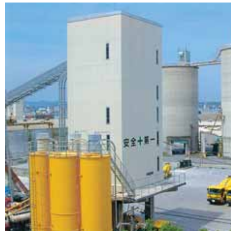
鹿児島で稼働中の高性能コンクリートプラント 「DASH-275」
