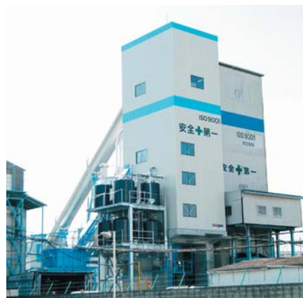
神奈川県で稼働中のコンクリートプラント 「DASH-330 S2」
