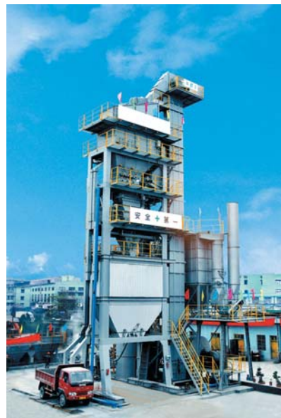
中国で稼働中の日工上海製 合材サイロ型アスファルトプラント
