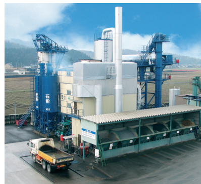
福井県で稼働中のアスファルトプラント 「NAP・BD-1000MBN」
