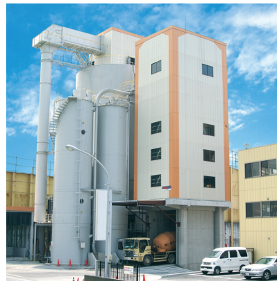
神奈川県で稼働中のコンクリートプラント 「DASH-330C2-ITB」
