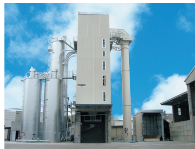
福岡県で稼働中のコンクリートプラント 「DASH-N275EvoⅣ」
