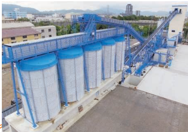
バッチャープラント
