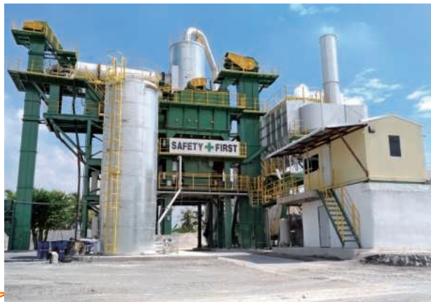
アスファルトプラント
