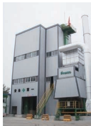
北京市朝阳区で稼働中の NBD320ABZ NRU・TOPα120-50AL
