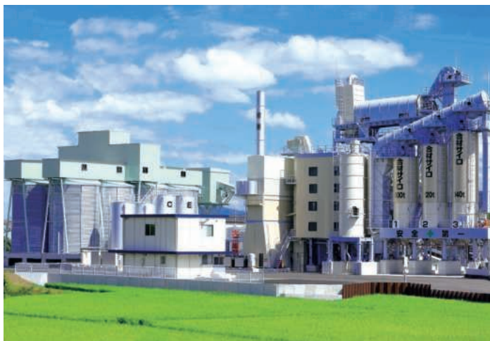
滋賀県で稼働中のアスファルトプラント
