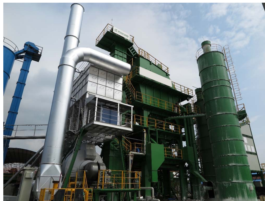
中国で稼働中の日工(上海)製のアスファルトプラント NBD320ABZ
