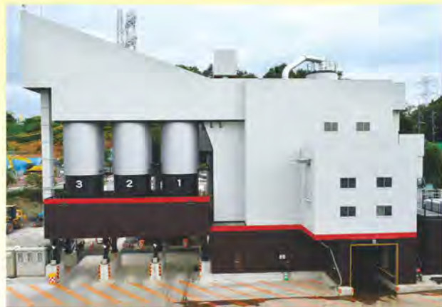
アスファルトプラント
