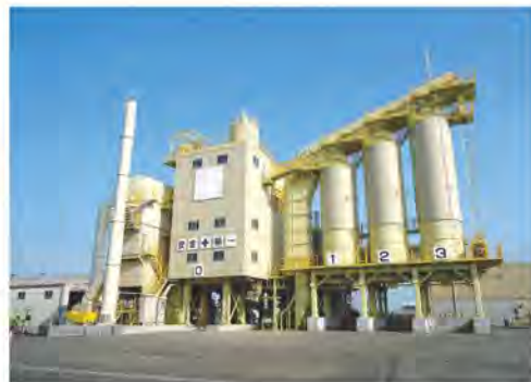
群馬県で稼働中のアスファルトプラント MBD-1600MBN+TOPα80-50AL
