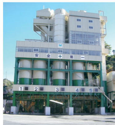
神奈川県で稼働中の アスファルトプラント EBD1600+ETOP60
