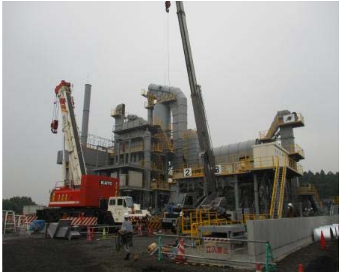
千葉県で工事中のアスファルトプラント NAP・ABD-2000CBN+NRU・α90-100AF
