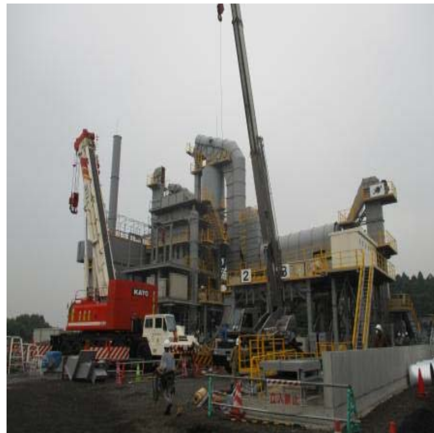
千葉県で工事中のアスファルトプラント NAP・ABD-2000CBN+NRU・α90-100AF
