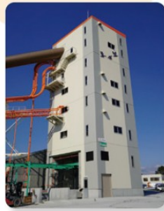
コンクリートプラント (BP関連事業)
