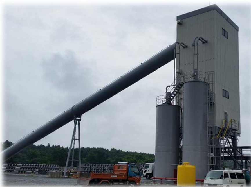
(コンクリートプラント/福島県)
