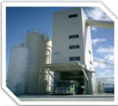
【コンクリートプラント /福井県福井市】
