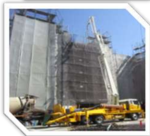
【コンクリートポンプ車 /大阪府 泉大津市】
