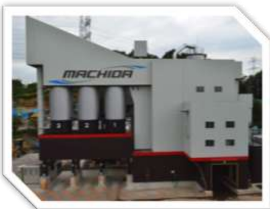
【アスファルトプラント /東京都町田市】
