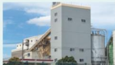
DASH-H275EvoV Twin-ADV 超高強度コンクリートプラント
