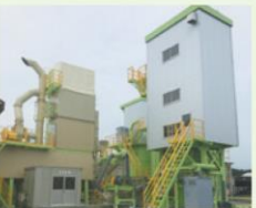
石膏系固化材製造設備 石膏粉を乾燥し半水石膏を製造。 セメントや石灰とブレンドし固 化材を製造する設備です。
