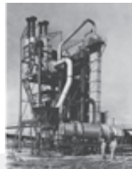
アスファルトプラント1号機 完成
