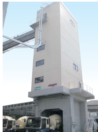
東京都で稼働中のコンクリートプラント DASH-N330Evo Ⅲ-150R-TRI
