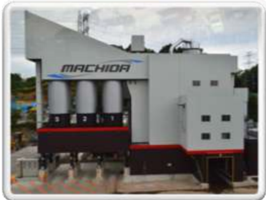
【アスファルトプラント/東京都】
