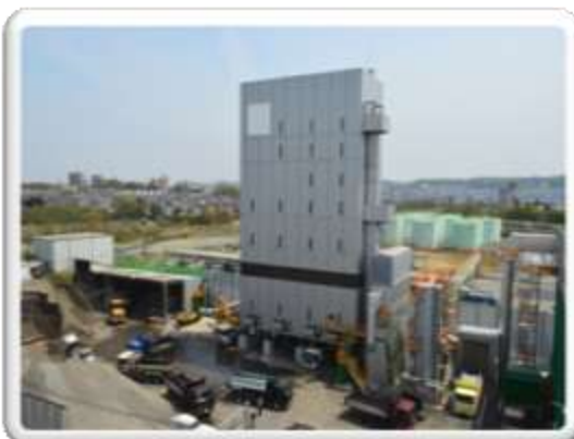
【アスファルトプラント/東京都】
