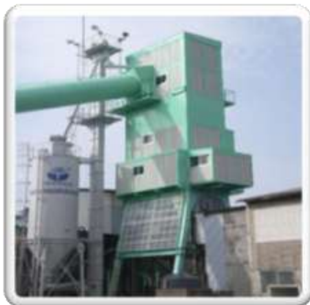
【コンクリートプラント /富山県富山市】
