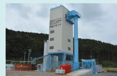
震災復興用プラントの投入
