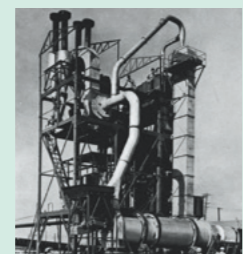
1958年アスファルトプラント1号機の完成
