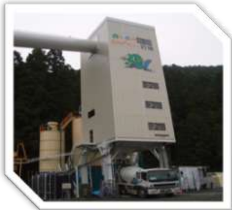
【コンクリートプラント /岩手県下閉伊郡岩泉町】
