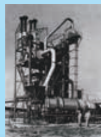
1958年 アスファルトプラント1号機の完成
