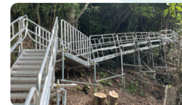
仮設機材 (その他事業)
