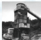
Uタイプコンクリートプラントの開発 (1977年)
