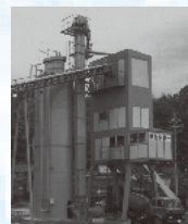
コンパクトコンクリートプラントの開発 (1979年)
