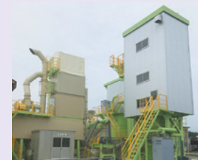
石膏系固化工材製造設備 乾燥した石膏粉から半水石膏を製造し、セメントや石灰とブレンドすることで固化工材を製造するプラント設備
