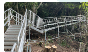
仮設機材 (その他事業)
