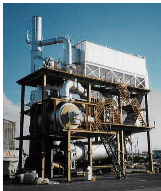
写真-6 RAVシステムの社内仮組風景
