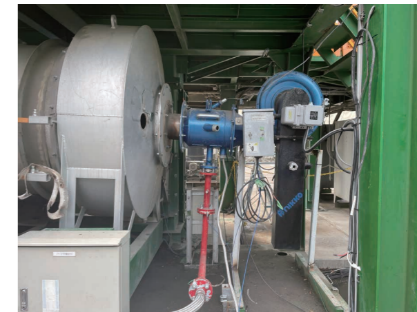
写真1 500kW級水素バーナ
