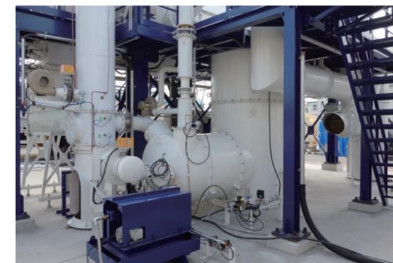
写真3-3 熱風発生炉
