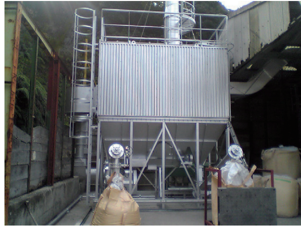
写真-6 定置式のパグフィルタ 2)
