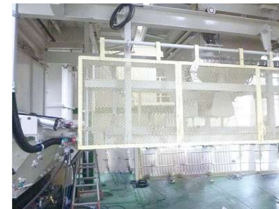
写真3 R材移動計量器 安全柵
