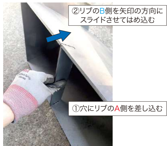
写真8 リブ板差込の様子
