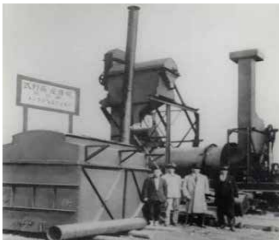
写真-1 1933年(昭和8年)製造の高野式APの3号機
