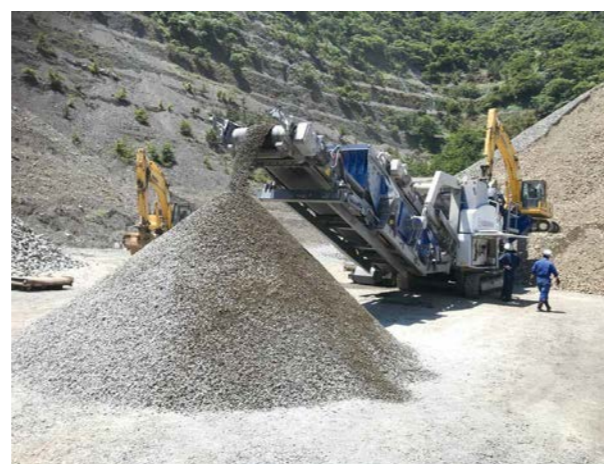
写真1 岐阜県現場 材料:硬質砂岩 100-0→20-0
