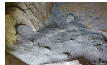
写真4-4. 運転後燃焼炉内
