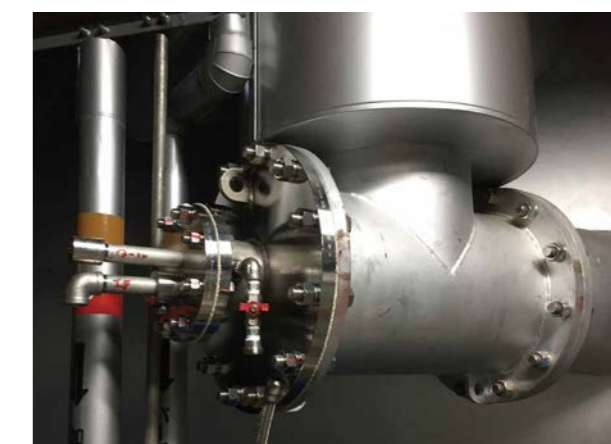
写真2-3. 加熱軽質タールノズル
