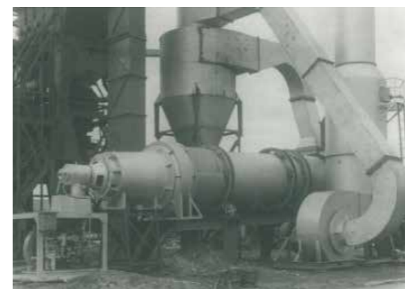
写真-5 旧型APの骨材乾燥システム
