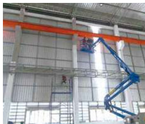
(写真54)工場建設風景45
