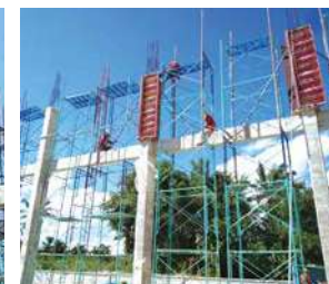
(写真23) 工場建設風景14
