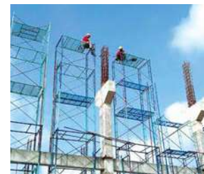
(写真24) 工場建設風景15
