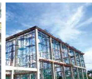
(写真29) 工場建設風景20
