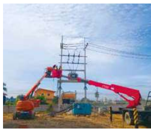
(写真56)工場建設風景47
