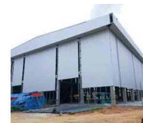
(写真40) 工場建設風景31
