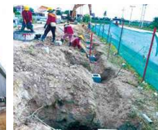
(写真41) 工場建設風景32
