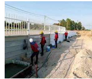
(写真70)工場建設風景61
