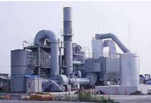
写真-4 NTR-Stage I(処理能力:毎時70トン)の全景
