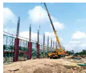
(写真18) 工場建設風景9
