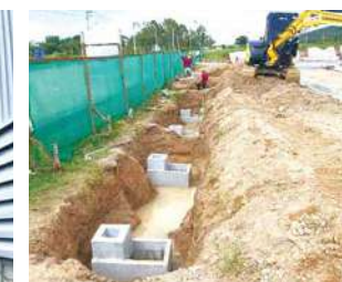
(写真45) 工場建設風景36
