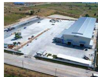
（写真2）完成後航空写真
