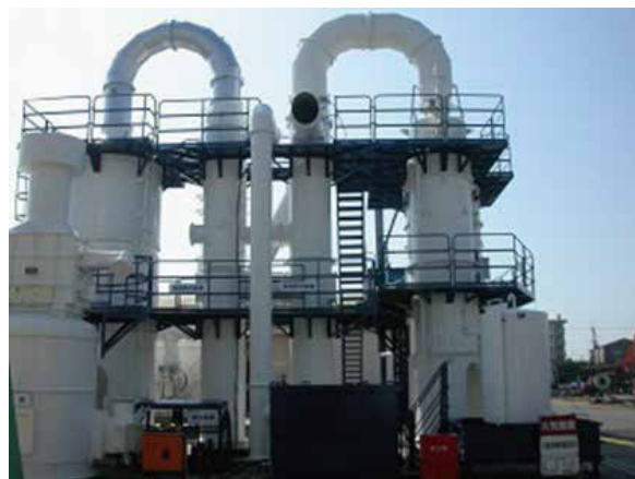
写真-8 NTR-Stage Vの社内実証機全景
