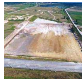
（写真1）着工前航空写真
