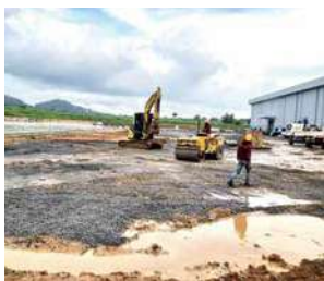
(写真51)工場建設風景42
