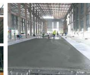
(写真39) 工場建設風景30
