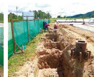
(写真43) 工場建設風景34
