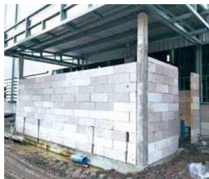
(写真52)工場建設風景43
