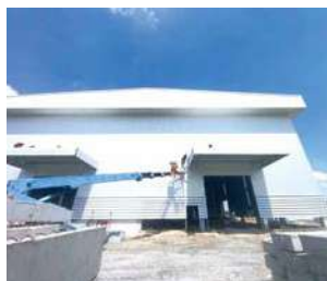
(写真50)工場建設風景41
