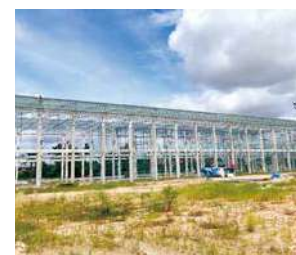
(写真30) 工場建設風景21
