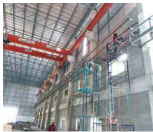
(写真48)工場建設風景39
