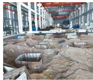
(写真69)工場建設風景60
