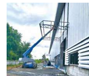
(写真44) 工場建設風景35
