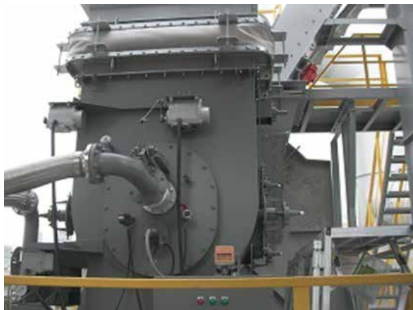
写真-17 NTR-StageⅥの一次処理装置用の予熱空気バーナ
