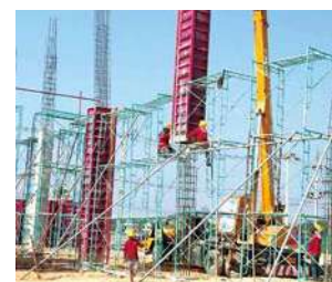
(写真19) 工場建設風景10
