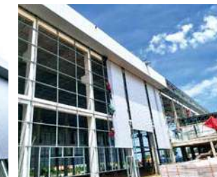
(写真37) 工場建設風景28
