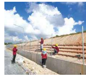
(写真72)工場建設風景63
