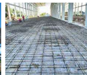
(写真33) 工場建設風景24
