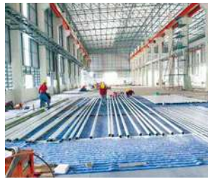
(写真58)工場建設風景49
