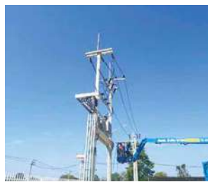
(写真68)工場建設風景59
