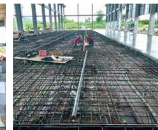
(写真35) 工場建設風景26
