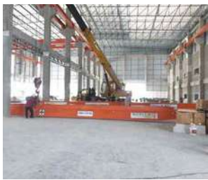
(写真49)工場建設風景40
