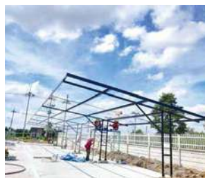
(写真62)工場建設風景53
