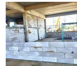
(写真34) 工場建設風景25
