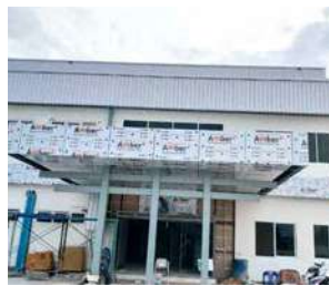
(写真60)工場建設風景51
