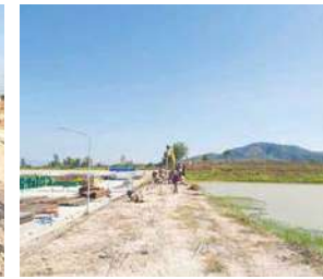
(写真71)工場建設風景62
