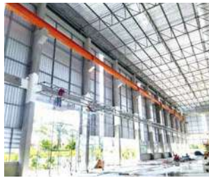
(写真46)工場建設風景37
