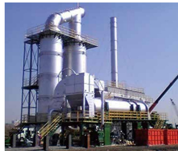
写真-7 NTR-Stage IVの全景
