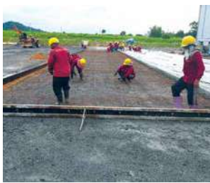
(写真57)工場建設風景48
