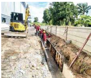
(写真55)工場建設風景46
