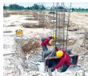
(写真16) 工場建設風景7
