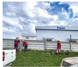
(写真61)工場建設風景52
