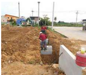
(写真53)工場建設風景44
