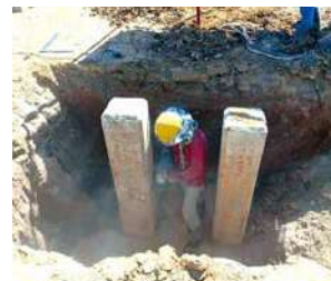
(写真12) 工場建設風景3
