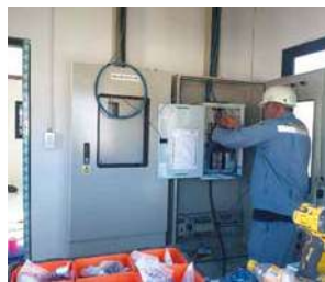
(写真64)工場建設風景55
