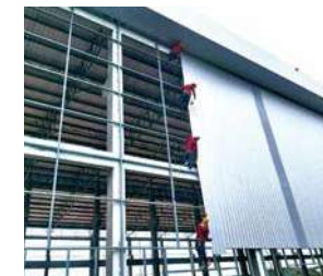
(写真36) 工場建設風景27
