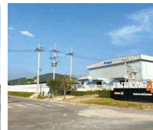
（写真4）タイ工場外観 （メイン道路から）
