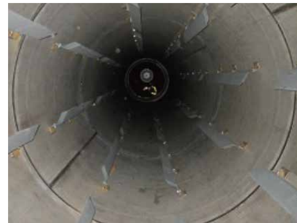
写真-11 NTR-Stage VIのプレヒートキルン内部
