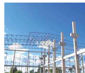
(写真26) 工場建設風景17
