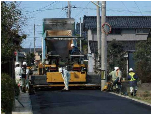
写真-2 アスファルト舗装による遮蔽 12)
