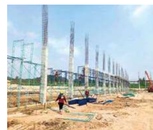
(写真21) 工場建設風景12
