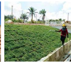
(写真73)工場建設風景64
