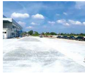
(写真59)工場建設風景50
