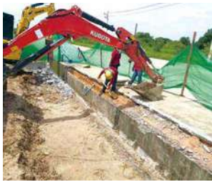
(写真47)工場建設風景38
