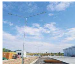
(写真65)工場建設風景56
