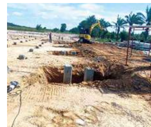
(写真13) 工場建設風景4
