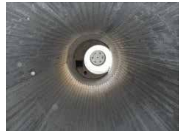
写真-15 NTR-Stage VIの一次処理装置内部
