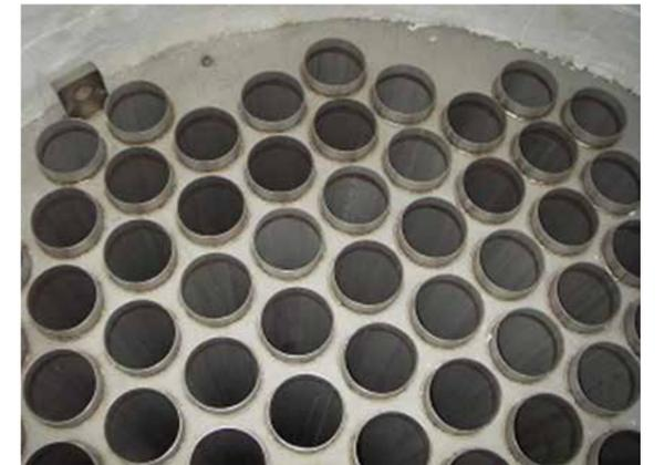
写真-19 熱交換器上部(チューブ内部に放熱側ガスが流入)
