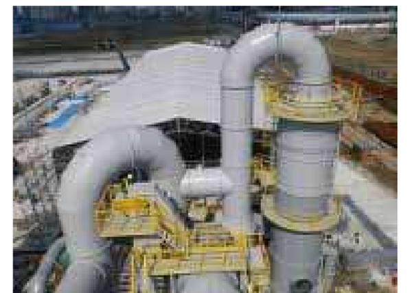
写真-20 左より、プレヒートキルン、熱交換器、冷却塔
