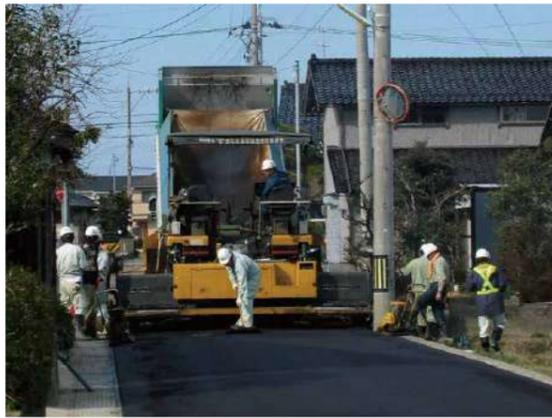
写真-2 アスファルト舗装による遮蔽<sup>12)</sup>
