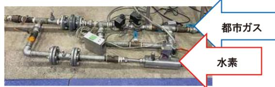
写真3-2 電磁弁ユニット
