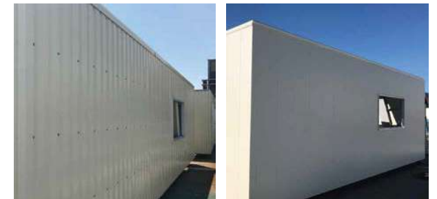
左:角波サイディング施工 右:VPIV採用の金属サイディング施工
