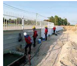
(写真70)工場建設風景61
