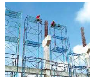
(写真24) 工場建設風景15
