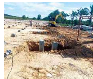
(写真13) 工場建設風景4
