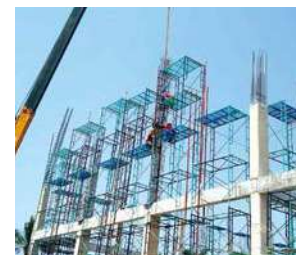
(写真22) 工場建設風景13
