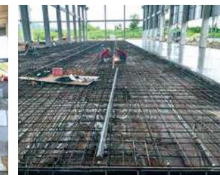
(写真35) 工場建設風景26
