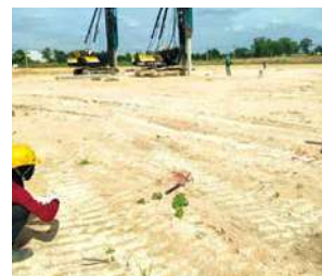
(写真10) 工場建設風景1
