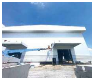
(写真50)工場建設風景41
