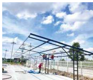
(写真62)工場建設風景53
