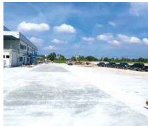
(写真59)工場建設風景50
