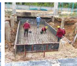
(写真27) 工場建設風景18
