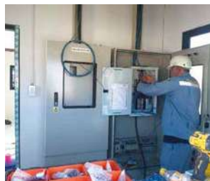
(写真64)工場建設風景55
