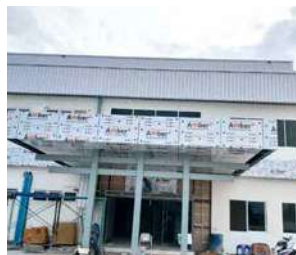
(写真60)工場建設風景51
