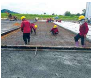
(写真57)工場建設風景48
