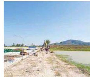
(写真71)工場建設風景62
