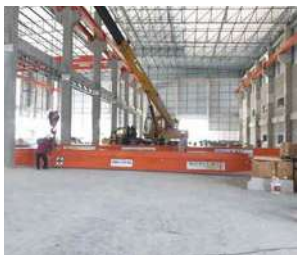
(写真49)工場建設風景40
