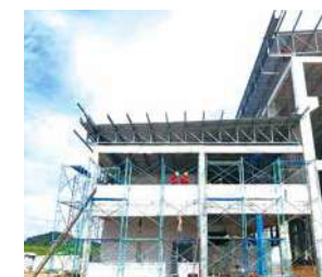
(写真38) 工場建設風景29
