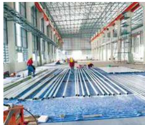
(写真58)工場建設風景49
