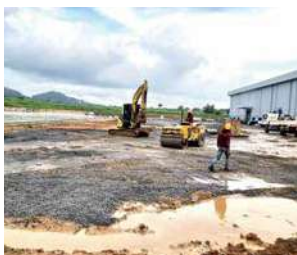
(写真51)工場建設風景42
