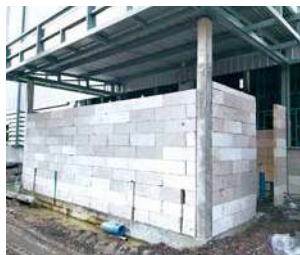
(写真52)工場建設風景43
