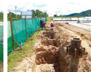
(写真43) 工場建設風景34
