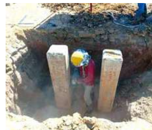
(写真12) 工場建設風景3
