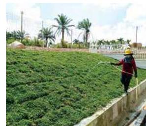
(写真73)工場建設風景64
