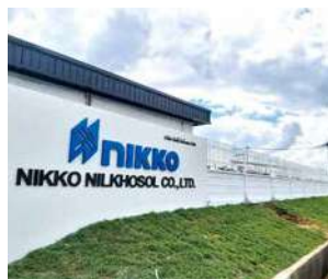
(写真63)工場建設風景54
