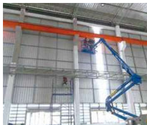
(写真54)工場建設風景45
