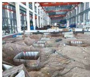
(写真69)工場建設風景60
