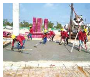
(写真20) 工場建設風景11
