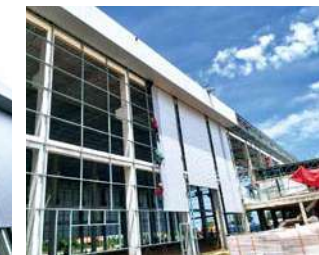
(写真37) 工場建設風景28
