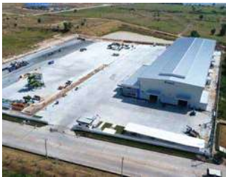
（写真2）完成後航空写真
