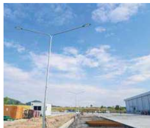
(写真65)工場建設風景56
