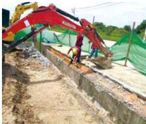
(写真47)工場建設風景38
