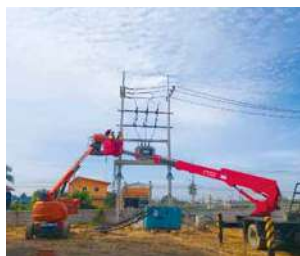
(写真56)工場建設風景47
