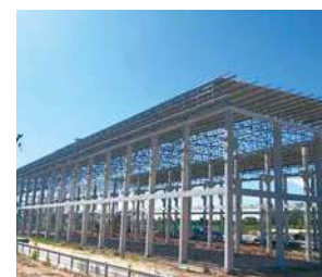
(写真32) 工場建設風景23
