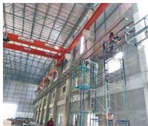
(写真48)工場建設風景39
