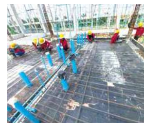
(写真28) 工場建設風景19
