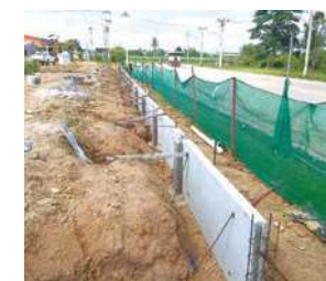
(写真42) 工場建設風景33
