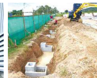
(写真45) 工場建設風景36
