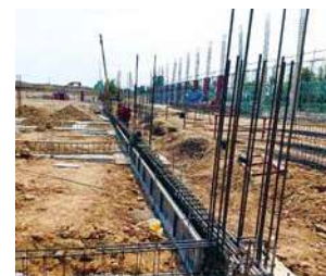
(写真17) 工場建設風景8
