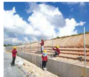
(写真72)工場建設風景63
