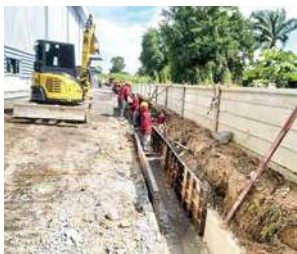
(写真55)工場建設風景46
