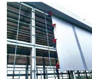
(写真36) 工場建設風景27
