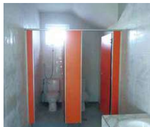
(写真67)工場建設風景58
