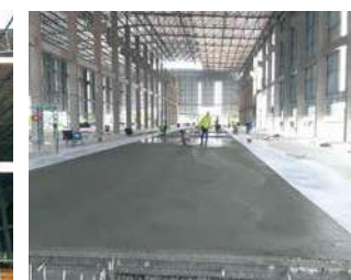
(写真39) 工場建設風景30
