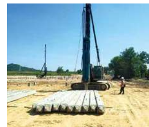
(写真11) 工場建設風景2
