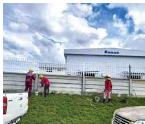
(写真61)工場建設風景52
