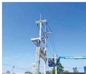
(写真68)工場建設風景59
