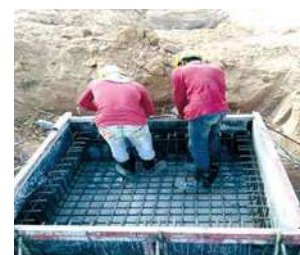
(写真15) 工場建設風景6
