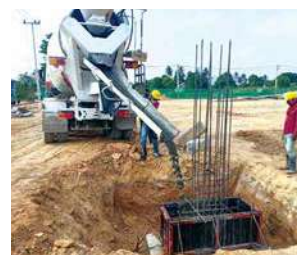
(写真14) 工場建設風景5
