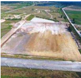
（写真1）着工前航空写真
