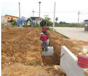
(写真53)工場建設風景44
