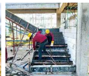
(写真31) 工場建設風景22
