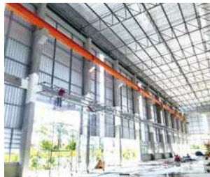
(写真46)工場建設風景37
