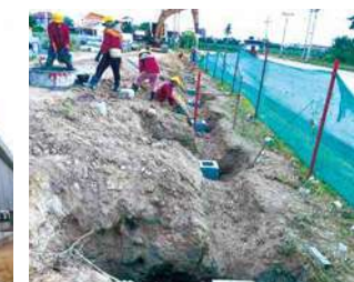
(写真41) 工場建設風景32
