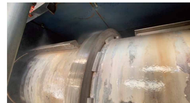
写真3-3 水噴霧の様子
