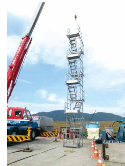
写真7 クレーンによる設置
