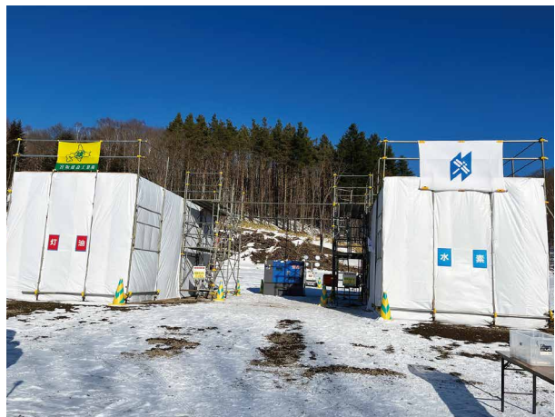
写真-2 実証試験の様子(陸別町)
