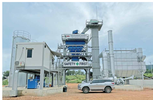
初号機のプラント全景(フレーム部材見直し)
