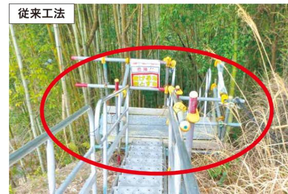
足場板、単管パイプ、緊結金具で構成された踊り場となります。急斜面での作業となり、危険が伴います。また、部材点数が多いので作業時間はかかります。
