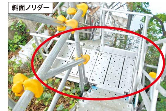
杭と単管パイプで地面に固定し、斜面ノリダーを設置して完成となります。手摺に関しては、ソケットにはめ込むだけで設置が出来るので組み立てる必要がありません。
