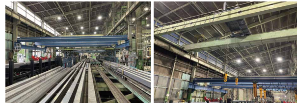
図5 新規供給装置架台 図6 無線化天井クレーン
